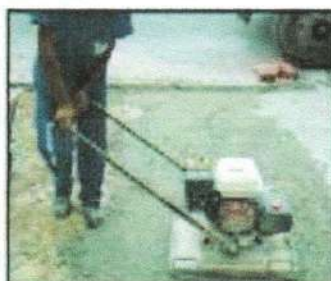
INSTALAÇÃO DAS CONTENÇÕES LATERAIS, NIVELAMENTO E COMPACTAÇÃO DA BASE.
