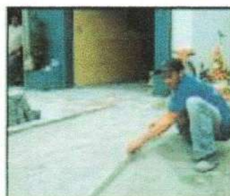
ESPALHAMENTO E NIVELAMENTO (SARRAFEAMENTO) DA ÁREA DE ASSENTAMENTO
