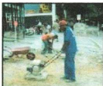
NIVELAMENTO E COMPACTAÇÃO DE SUBLEITO (TERRENO)
