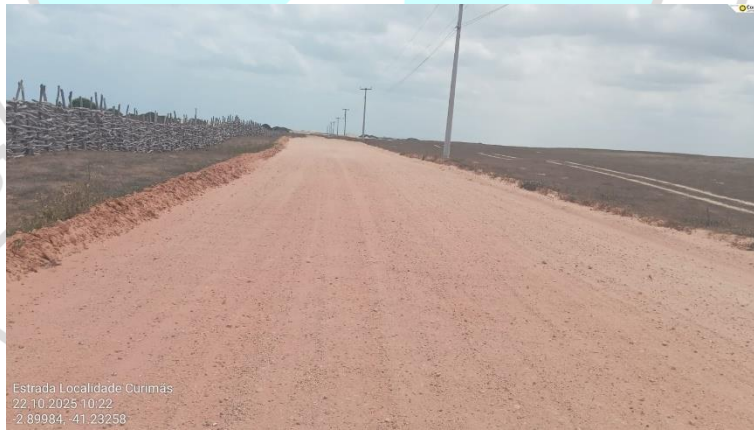
Foto 09: Situação do trecho meio da estrada que sofrerá intervenção
