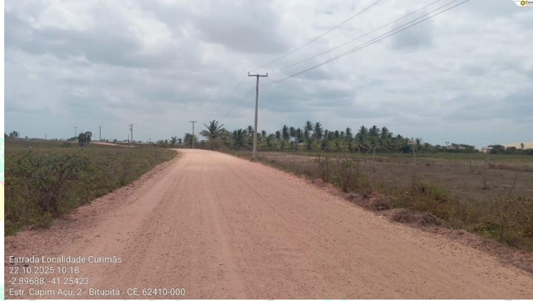
Foto 02: Situação do trecho meio da estrada que sofrerá intervenção
