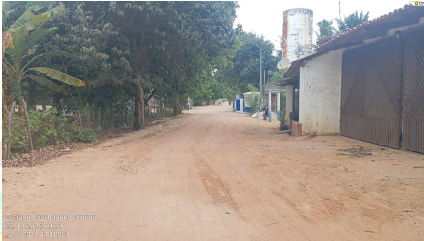
Foto 15: Situação do trecho meio da estrada que sofrerá intervenção
