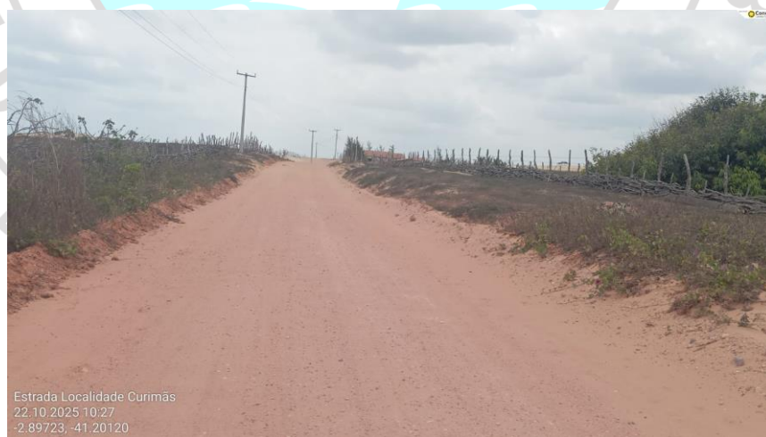
Foto 11: Situação do trecho meio da estrada que sofrerá intervenção
