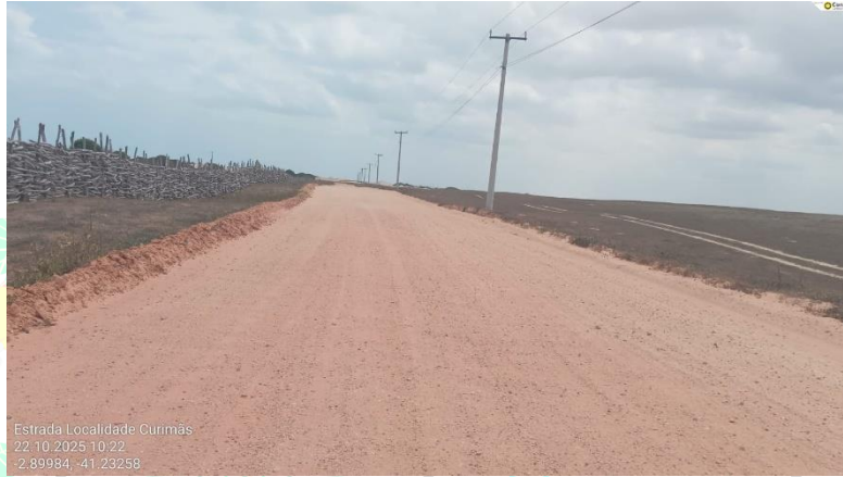
Foto 08: Situação do trecho meio da estrada que sofrerá intervenção
