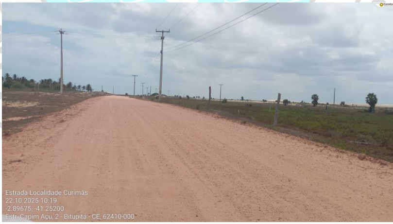
Foto 05: Situação do trecho meio da estrada que sofrerá intervenção
