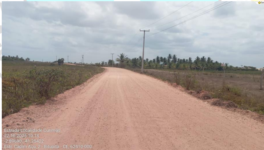
Foto 03: Situação do trecho meio da estrada que sofrerá intervenção
