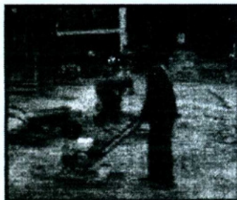
NIVELAMENTO E COMPACTAÇÃO DE SUBLEITO (TERRENO)
