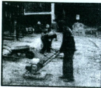
NIVELAMENTO E COMPACTAÇÃO DE SUBLEITO (TERRENO)
