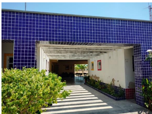
Foto 01 – Vista frontal da Edificação
