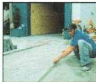
ESPALHAMENTO E NIVELAMENTO (SARRAFEAMENTO) DA AREIA DE ASSENTAMENTO
