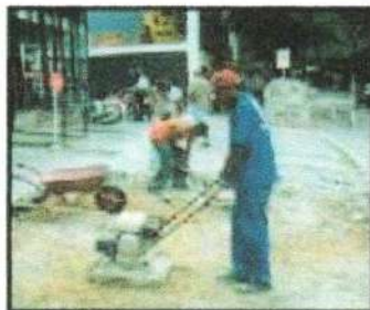
NIVELAMENTO E COMPACTAÇÃO DE SUBLEITO (TERRENO)
